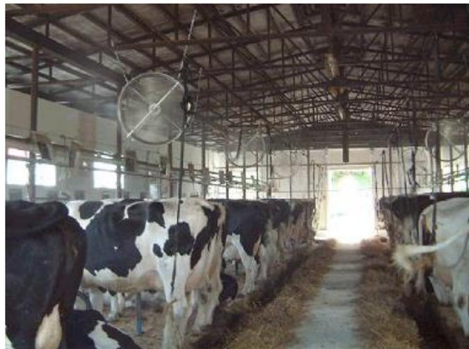
写真17 吊り下げ送風機と細霧システムによる暑熱対策事例
