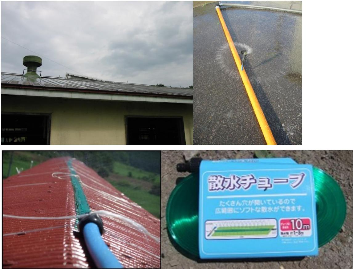
写真16 屋根への散水による暑熱対策事例
