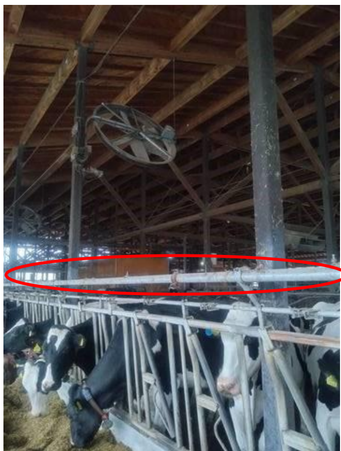
写真15 【ソーカーシステム事例】
