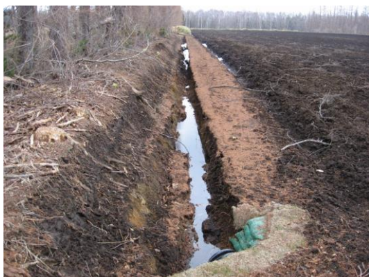
写真2 ほ場周縁に設置した簡易排水
